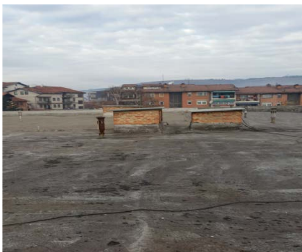
Kućice na krovu i poc. ventilacije
